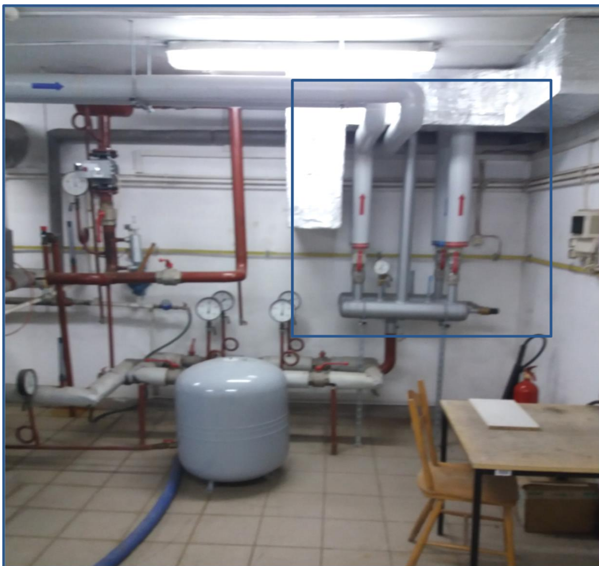
10.1 Zdjęcie rozdzielacza zlokalizowanego w pomieszczeniu kotłowni.
